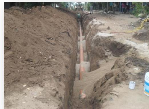
Instalación de línea de Alcantarillado Sanitario Serie 20 de 10" – 370.50 ml
