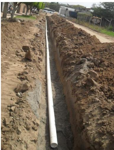
Instalación de línea de Alcantarillado PVC San. Serie 20 en 10” –
