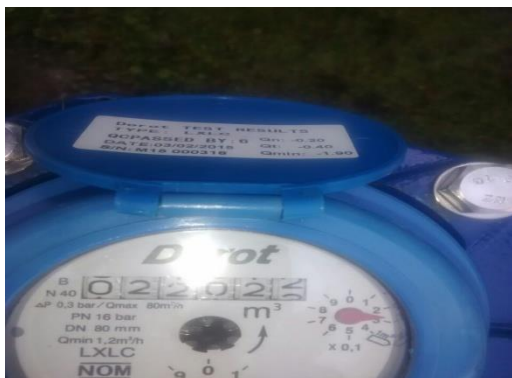
Pozo 36 A Lo De Marcos
