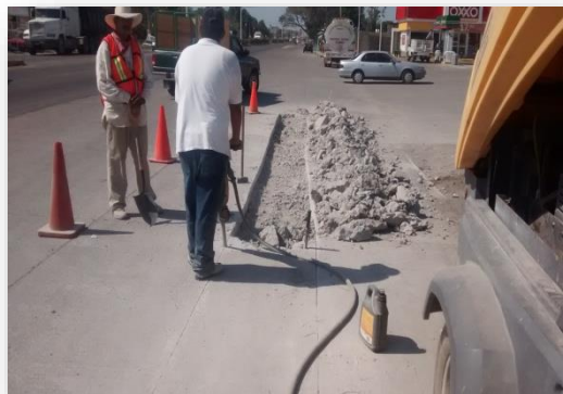
Instalación de línea de Alcantarillado Sanitario Serie 20 de 10" – 300.00 ml
