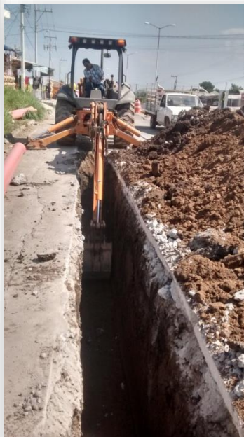
Instalación de línea de Alcantarillado Sanitario Serie 20 de 10" – 300.00 ml
