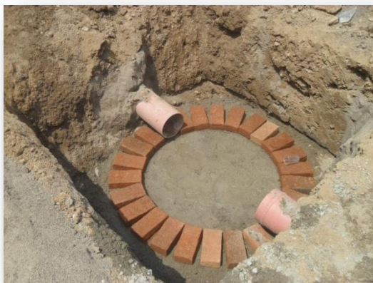
Instalación de línea de Alcantarillado PVC San. Serie 20
