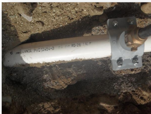
Instalación línea de Agua Potable RD-26 516.00 ml de toma domiciliaria
