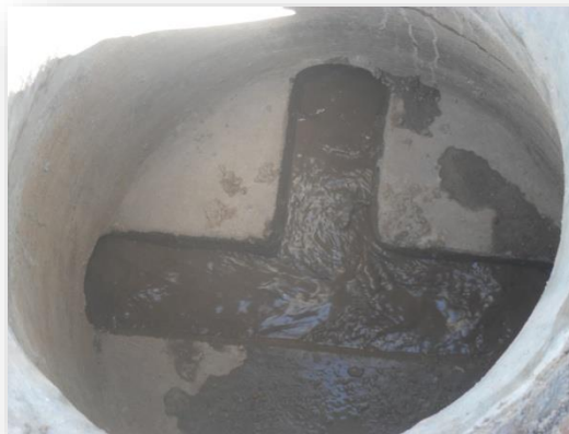
Prueba de Esgurrimiento en línea de Alcantarillado
