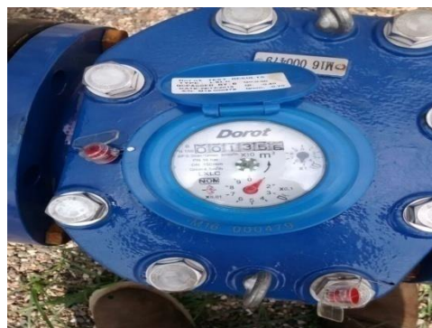
Pozo 23 Jarretaderas Ingreso
