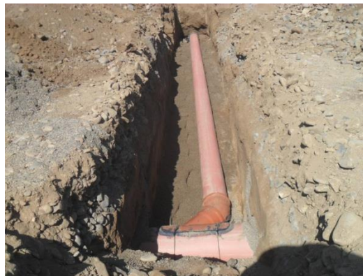
Instalación de línea de Alcantarillado Sanitario de 10" PVC Sanitario Serie-20
