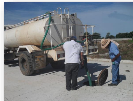
Prueba de Esgurrimiento en línea de Alcantarillado
