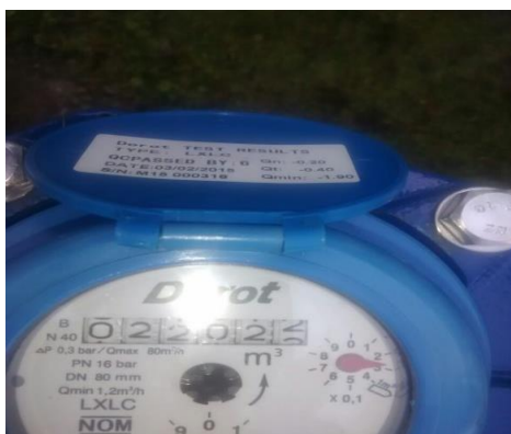
Pozo 36 A Lo De Marcos
