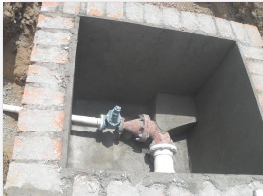
Construcción de Caja de Válvulas
