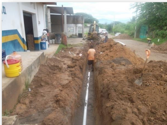
Instalación de línea de Agua Potable en PVC Hco. RD-26 2" y 3" - 1,383.00 ml
