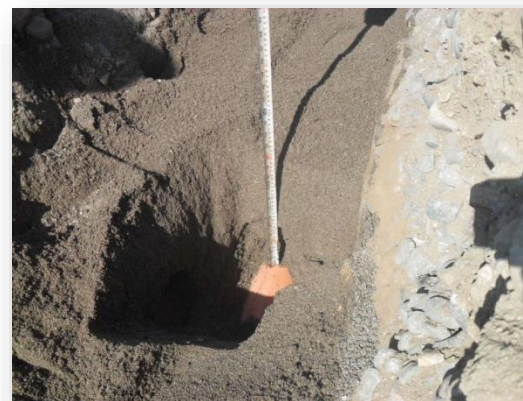
Acostillado de tubería
