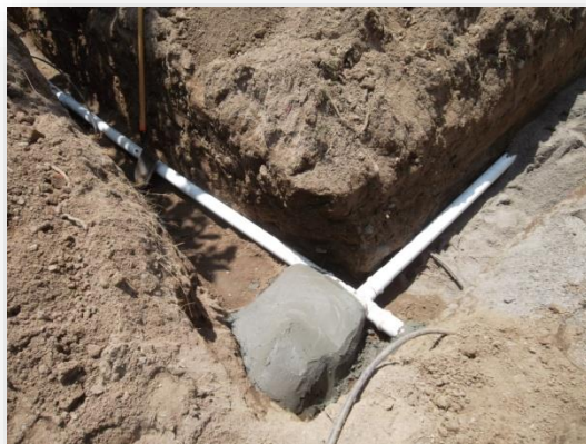
Instalación de línea de Agua Potable en PVC Hco. RD-26 2" y 3" - 1,383.00 ml
