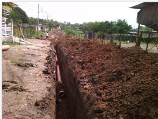
Instalación de línea de Alcantarillado Sanitario de 10" PVC Sanitario Serie-20 - 278.00 ml
