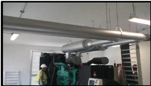
**Obra eléctrica.-** Colocación de tubos silenciadores de la planta de emergencia de 1000 KW
