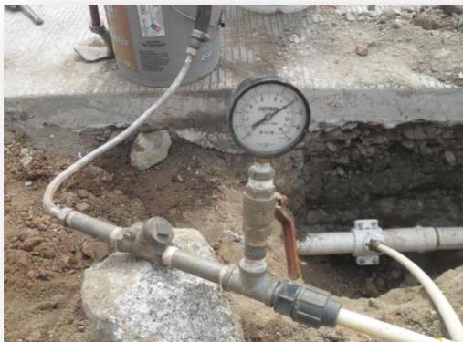
Realización de prueba hidrostática en tubería de Agua Potable
