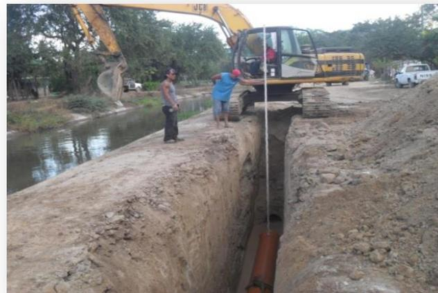
Trabajos de plantilla y acostillado con arena a tubo de 20” de pvc sanitario serie 20.
