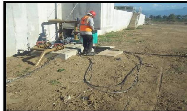
**Obra eléctrica.-** Cableado de circuitos de fuerza, control e instrumentación de bombas de cavidad progresiva, instaladas en el cárcamo de bombeo de lodos (CBL) y en digestores de lodos (DL-01/02)
