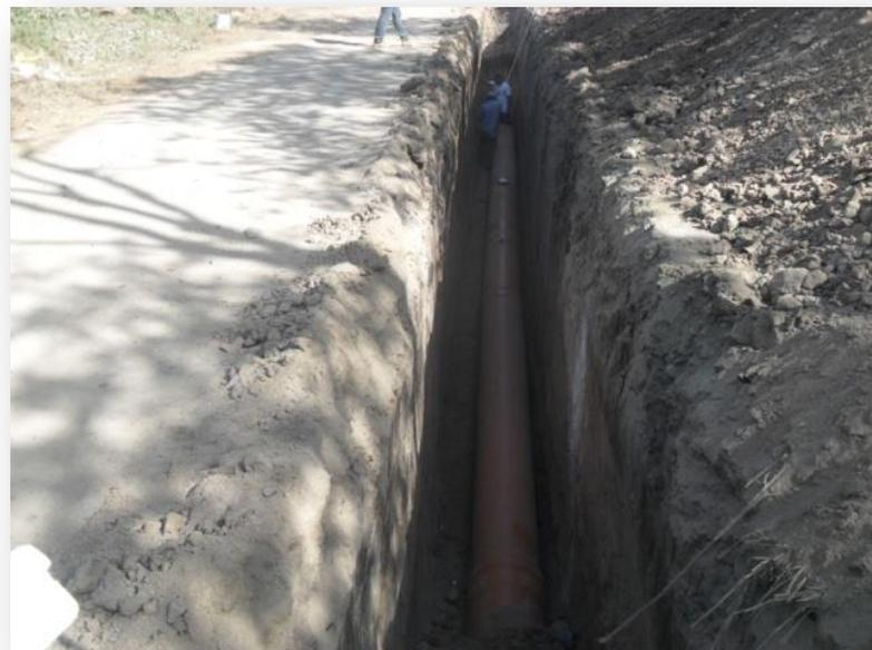
Trabajos de excavación e instalación de tubería de 20" de pvc sanitario serie 20.
