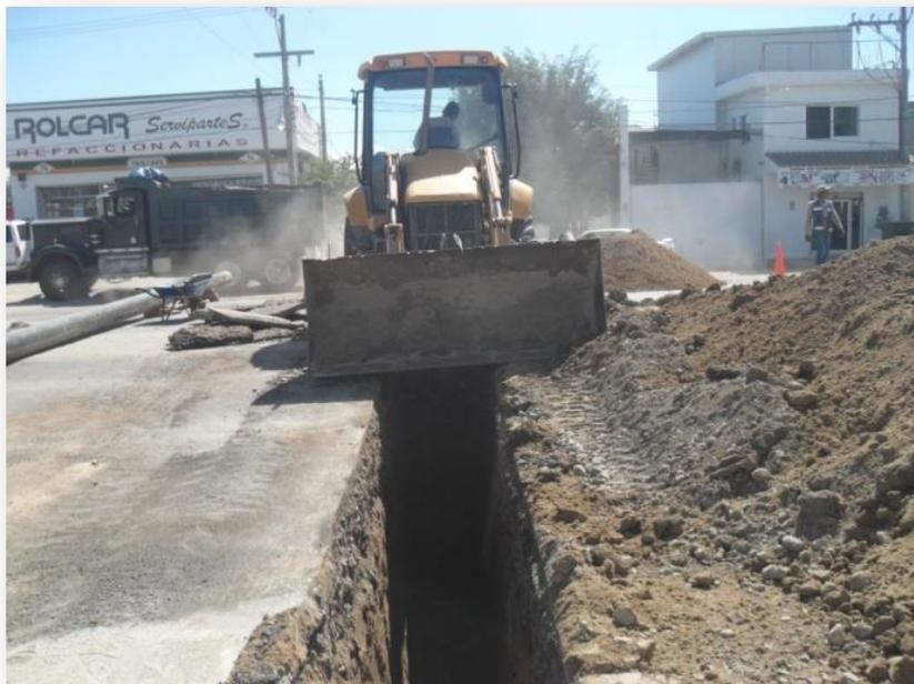
Excavación para cruce de tubería sobre Carretera Mezcales- San Vicente.
