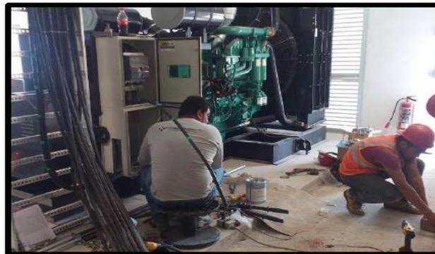
**Obra eléctrica.-** Instalación de gabinetes y conexiones eléctricas en planta de emergencia de 1000 KW
