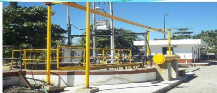
**Cárcamo Mezcales.-** Ya se cuenta con instalación de estructuras para soporte de polipasto y puente grúa, faltando llegada de las bombas. retiro de infraestructura en cárcamo existente e interconexiones de colectores
