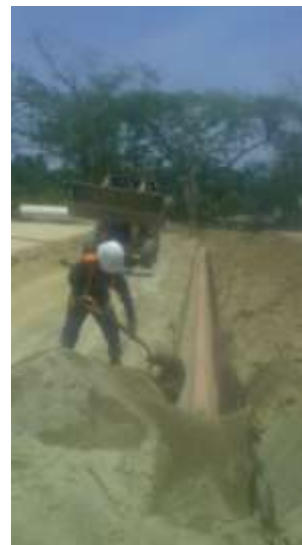
Instalación de línea de Alcantarillado PVC San. Serie 20 en 10" – 181.40 ml
