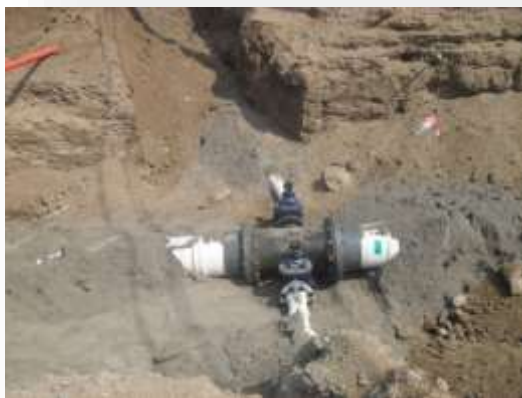
Instalación de línea de Agua Potable PVC Hco. RD-26 en 2" – 362.98 ml
