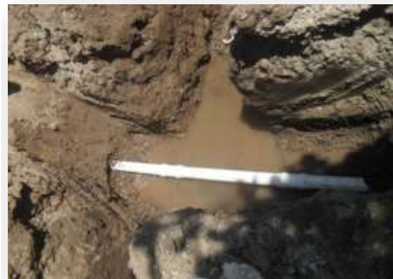
Instalación de línea de Agua Potable PVC Hidráulico RD-26 en 3" - 800.00 ml,
