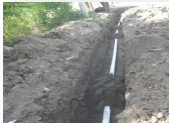
Instalación de línea de Agua Potable PVC Hidráulico RD-26 en 3" - 800.00 ml,
