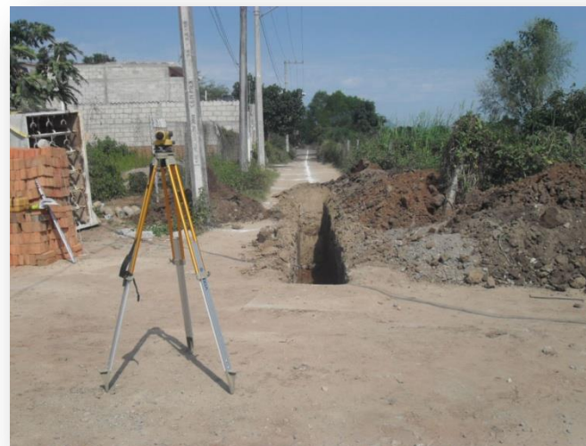
Trazo de Línea de Alcantarillado
