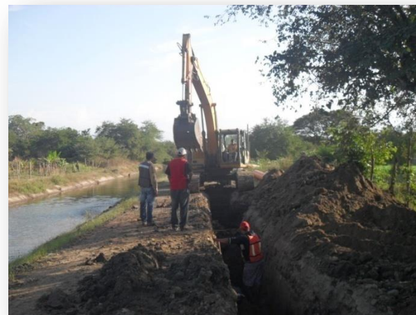
Trabajos de Instalación de tubería y plantilla con arena a tubo de 20" de pvc sanitario serie 20.
