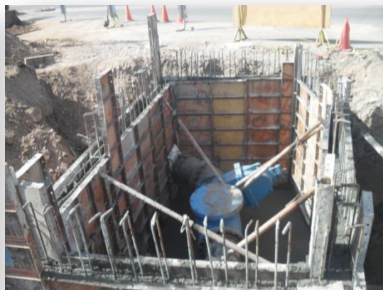
Construcción de Caja
