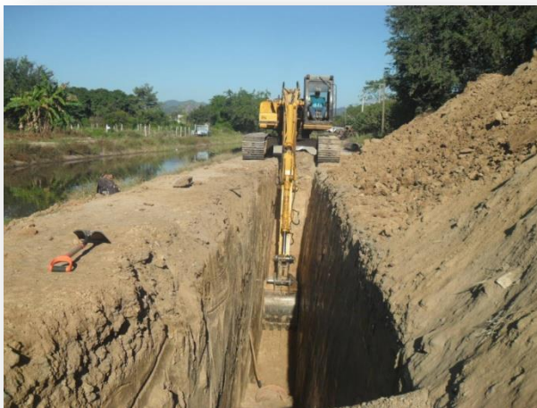
Trabajos de Instalación de tubería y plantilla con arena a tubo de 20" de pvc sanitario serie 20.
