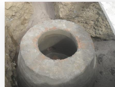
Acostillado de Tubería y Realización de Pozo de Visita
