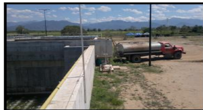
Pruebas y puesta en marcha: Vertido de lodos de PTARS externas para inoculación de materia biológica en el reactor.
