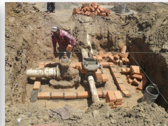
Colocación de Caja de Válvulas
