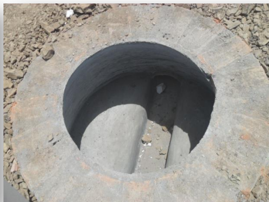
Instalación de Descarga Domiciliaria y Pozo de Visita
