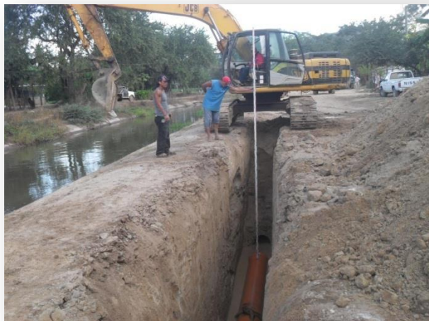
Trabajos de Instalación de tubería y plantilla con arena a tubo de 20" de pvc sanitario serie 20.
