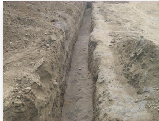
Instalación de Descarga Domiciliaria
