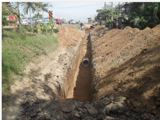
Instalación de línea de
