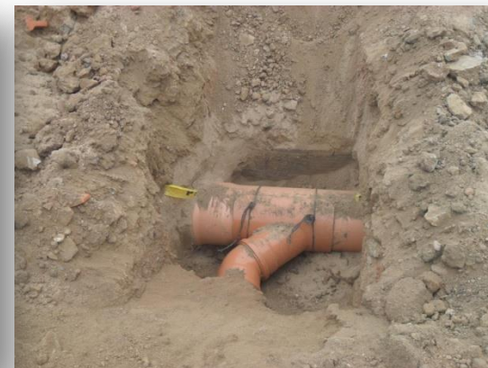
Instalación de Descarga Domiciliaria y Pozo de Visita
