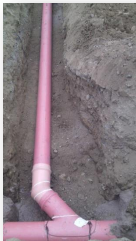
Instalación de Descarga Domiciliaria
