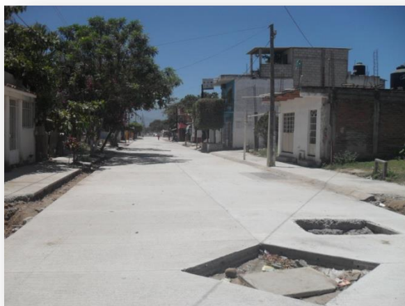
Instalación de Descarga Domiciliaria.
