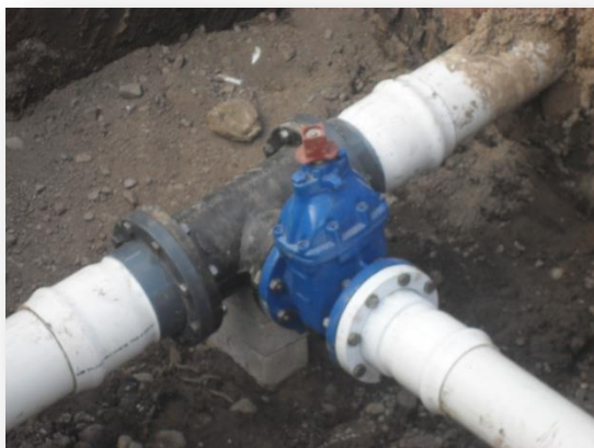
Instalación de línea de Agua Potable
