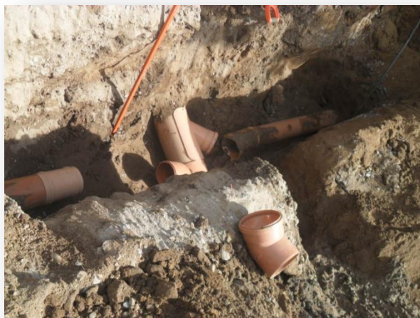
Instalación de Descarga Domiciliaria.
