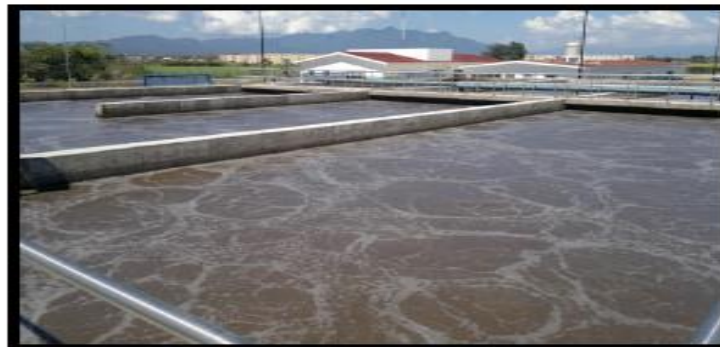
Pruebas y puesta en marcha.-Control de la concentración del aire manipulando las válvulas del sistema.
