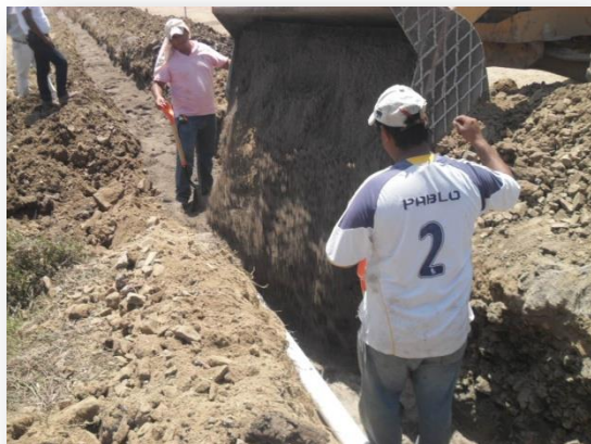
Acostillado Línea de Agua Potable
