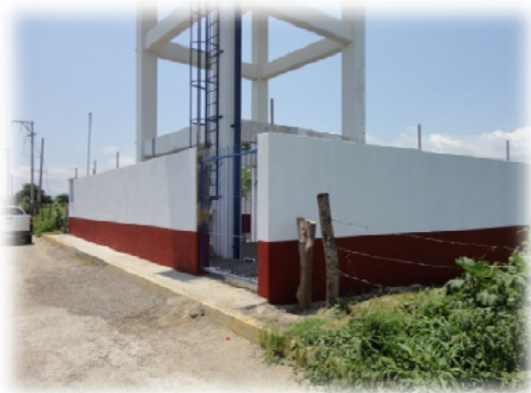
TANQUE No. 2 EN SAN JOSE DEL VALLE
