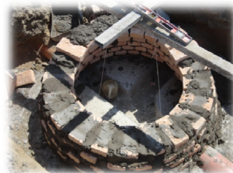
POZO DE VISITA
