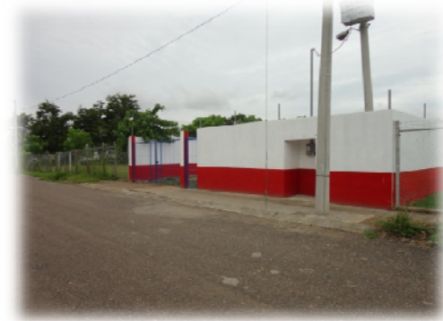
POZO No. 1 JARDINES DEL SOL
