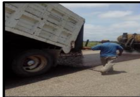
Camino de acceso.- Se aplicó riego de impregnación en el cad. 0+185 al 0+440, protegido con arena
