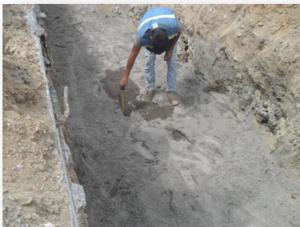
Demolición de Concreto
