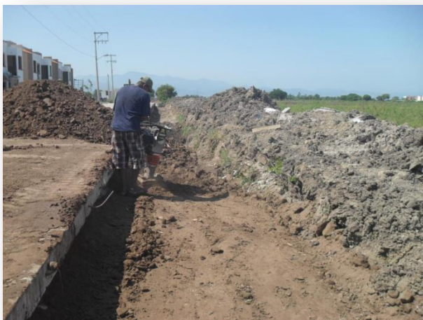
Compactación de terreno
