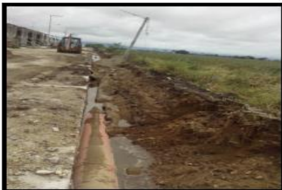
Colector San Vicente.-Se trabaja en la corrección de tubería instalada de pvc de 20", debido a las lluvias
