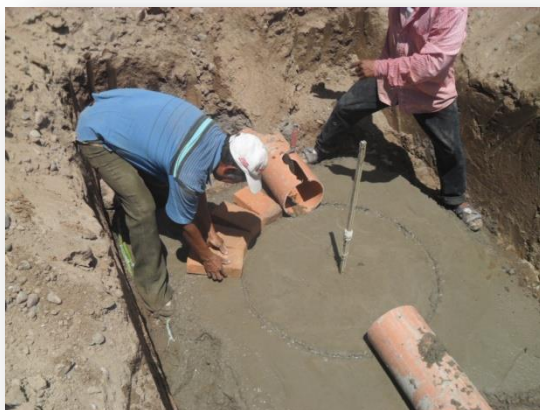
Elaboración de pozo de visita
