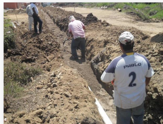
Acostillado Línea de Agua Potable
