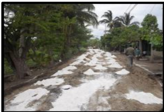
Camino de acceso.- Se adicionó cal para rehabilitación de base existente del cad 3+060 a 2+700.
