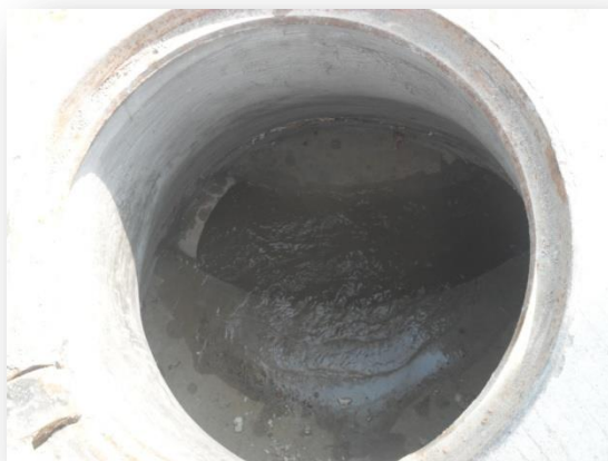
Prueba de Esgurrimiento
