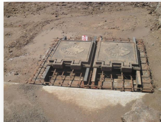
Colocación de Caja de Válvulas
