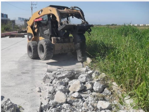
Demolición de Concreto
