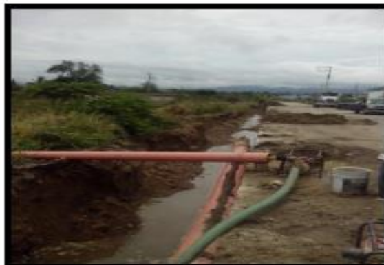
Colector San Vicente.-Se trabaja en la corrección de tubería instalada de pvc de 20", debido a las lluvias
