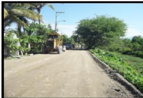
Camino de acceso.- Tendido de base existente rehabilitada en último tramo, del cad 3+060 a 2+700.
