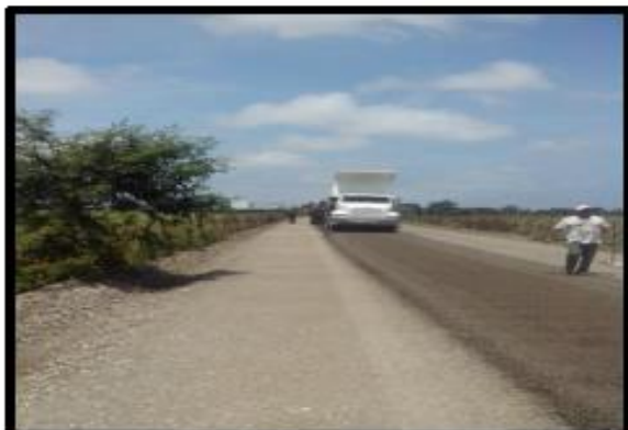
Camino de acceso.- Se aplicó riego de impregnación en el cad. 0+185 al 0+440, protegido con arena
