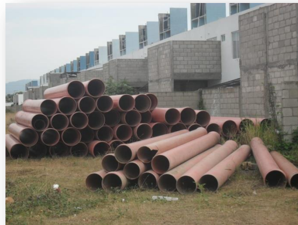
Suministro de Tubería de PVC HCO. de 20"
