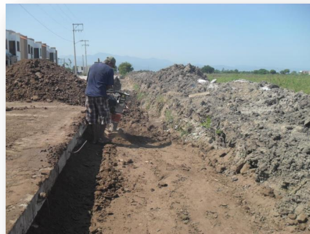
Compactación de terreno
