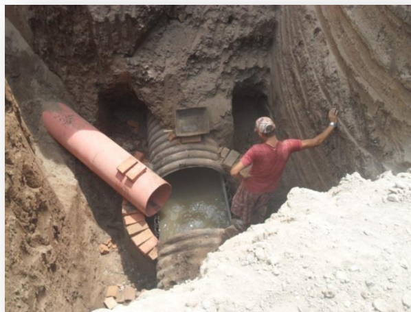
Entronque de tubería de 20" a Colector General de 60" de diámetro.
