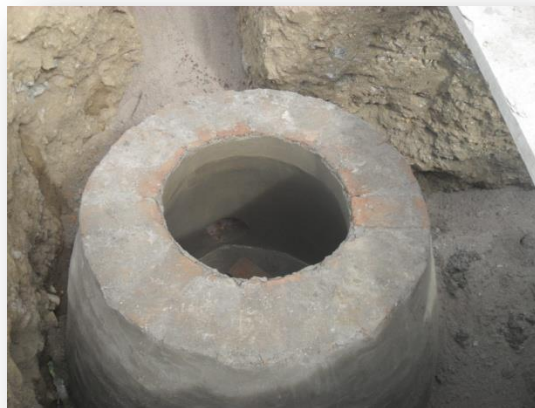
Realización de Pozo de Visita
