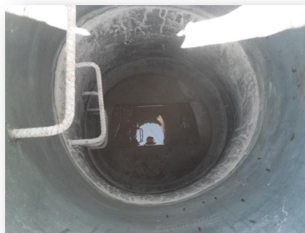
Construcción de Pozo de Visita
