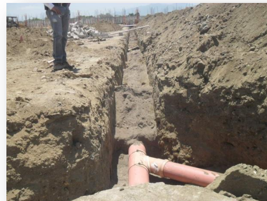
Acostillado de tubería de Alcantarillado Sanitario
