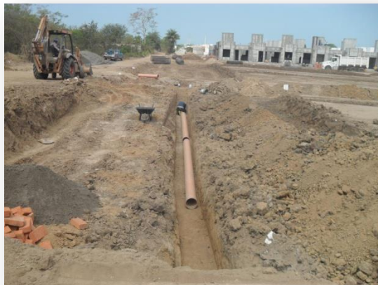
Instalación de línea de Alcantarillado
