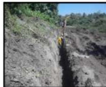
**Subcolector el Porvenir.**- Se realizan trabajos de excavación para instalación de tubería pvc de 10" de diámetro.
