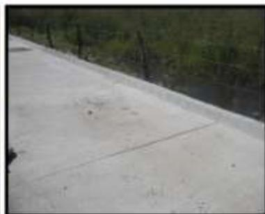
**Colector Sn. Vicente.**- Se trabaja en el calafateo de juntas de concreto en vialidad donde se colocó el colector.
